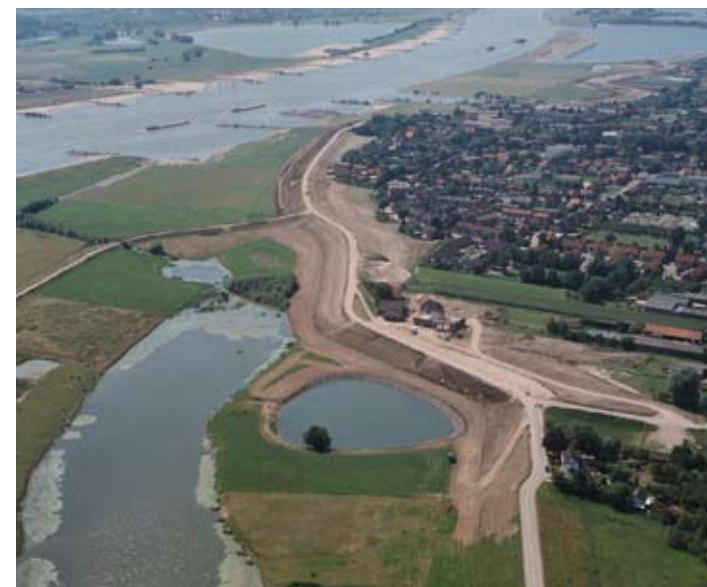
Dijkverzwaring langs de Waal bij Ochten in de zomer van 1995. Na het hoogwater van 1995 werden de in het Deltaplan Grote Rivieren aangekondigde dijkverzwaring ongekend snel uitgevoerd.
