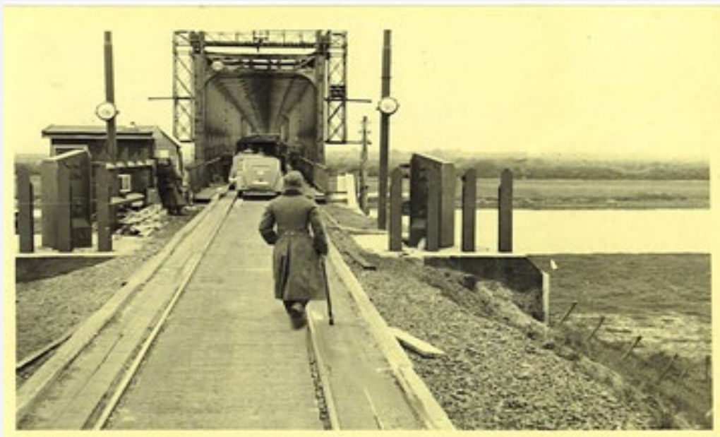
De spoorbrug over de Maas op 10 mei 1940, na de overval. De spoorbrug is gereed gemaakt voor trucks en pantserwagens. De veerpont was opgeblazen
