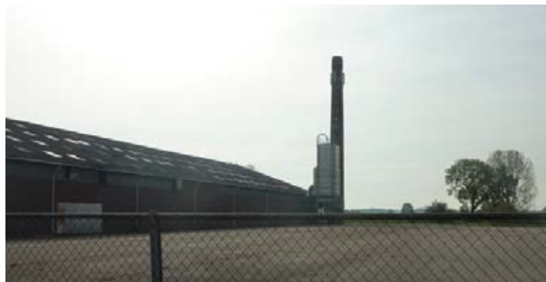
In het gebied liggen restanten van economieën uit het verleden, zoals de reeds gesloten Steenfabriek bij Milsbeek
